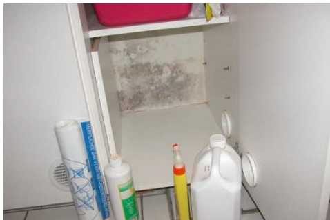
Foto 39.6 : Schimmels aan de binnenkant van een kast
